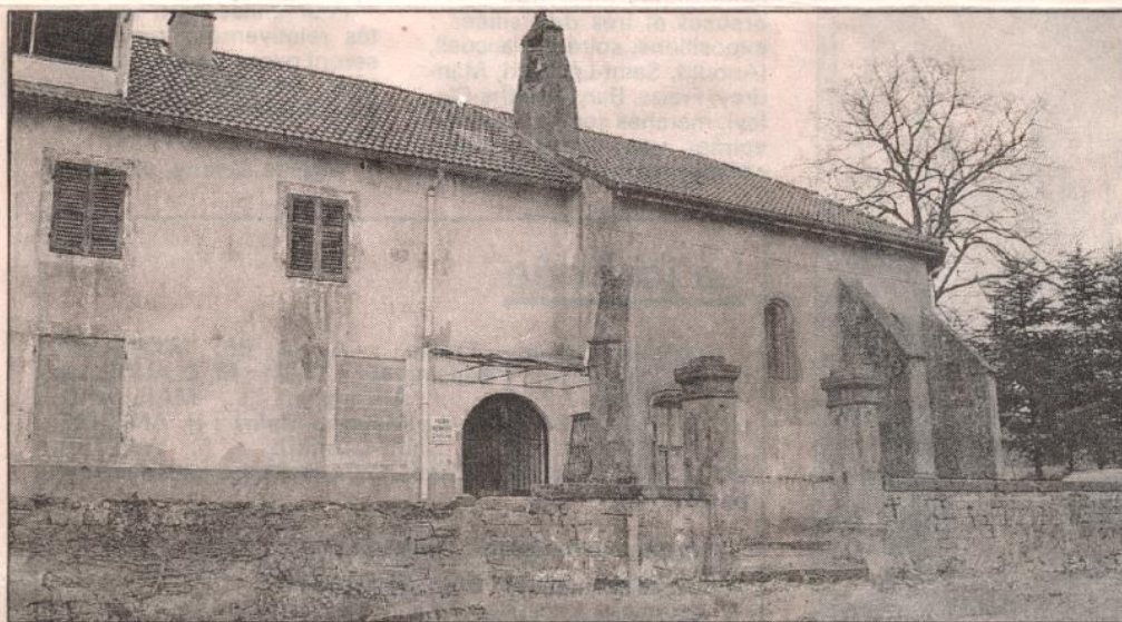
La chapelle et la ferme attenante donnent indéniablement la vision d'un site à l'abandon avec, entre autre détails, porte taguée et muret effondré.
