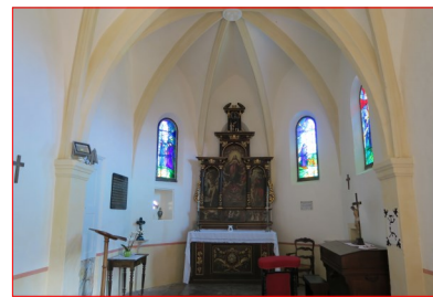
Réfection des badigeons 2014-2015
